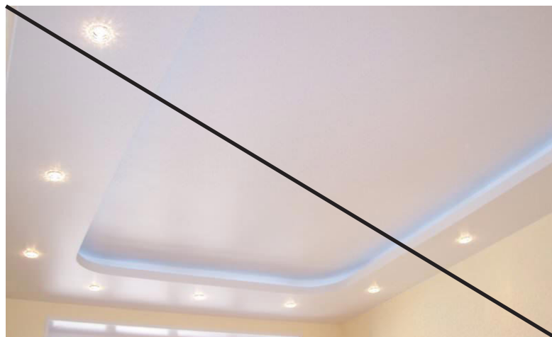
Плохо Многоуровневые гипсокартонные конструкции
